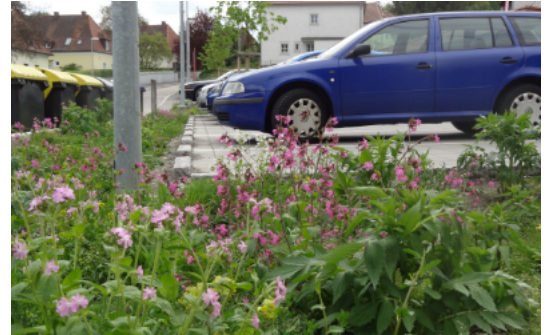
Sickermulde an Parkplatz
