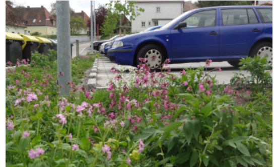
Sickermulde an Parkplatz
